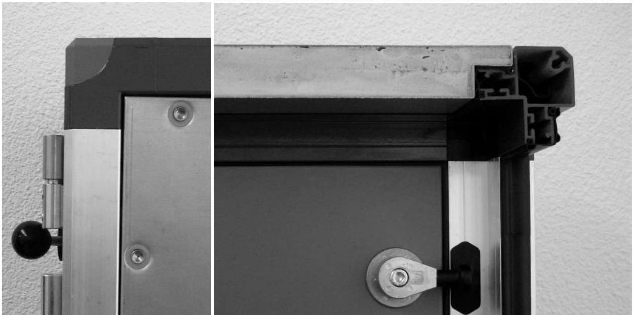
Abbildung 1: Detailansicht Drehriegelverschluss und Scharnier
